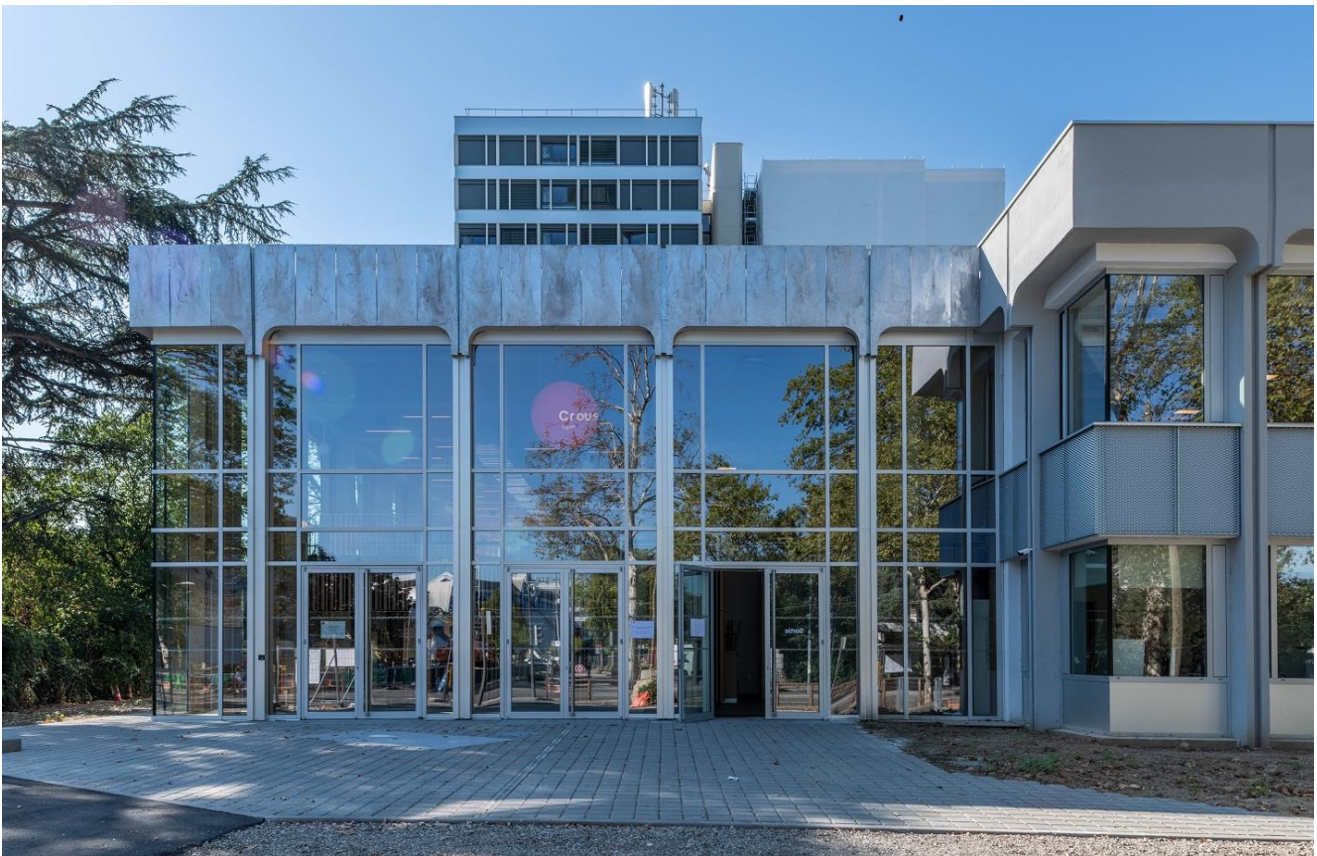
Restauration Puyis réhabilité
