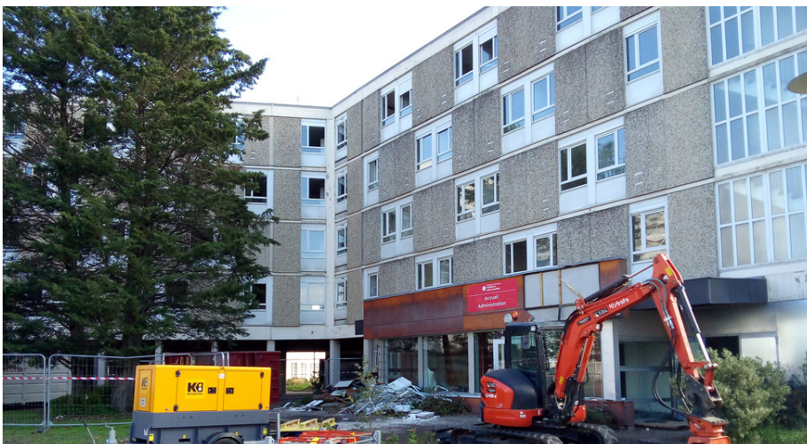
Cité Mermoz avant démolition - 600 chambres avec sanitaires collectifs
